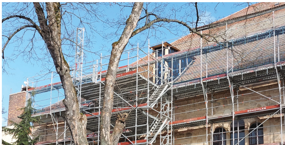
Dachgaube auf der Westseite für einen leichteren Eintritt in das Dachgestühl.
